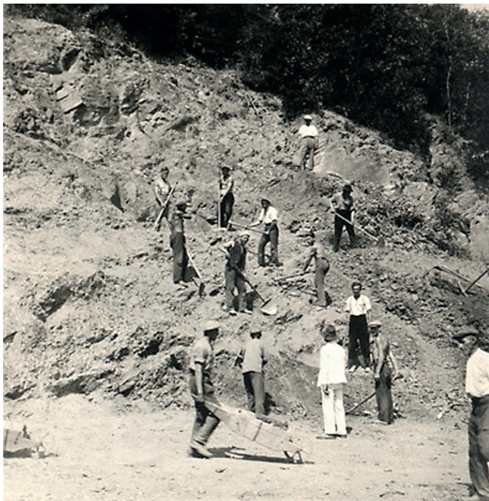
Nezaměstnaní stavební dělníci pracují na úpravě terénu pražské zoo Unemployed "hard hats" from Prague landscaping the future zoological garden
