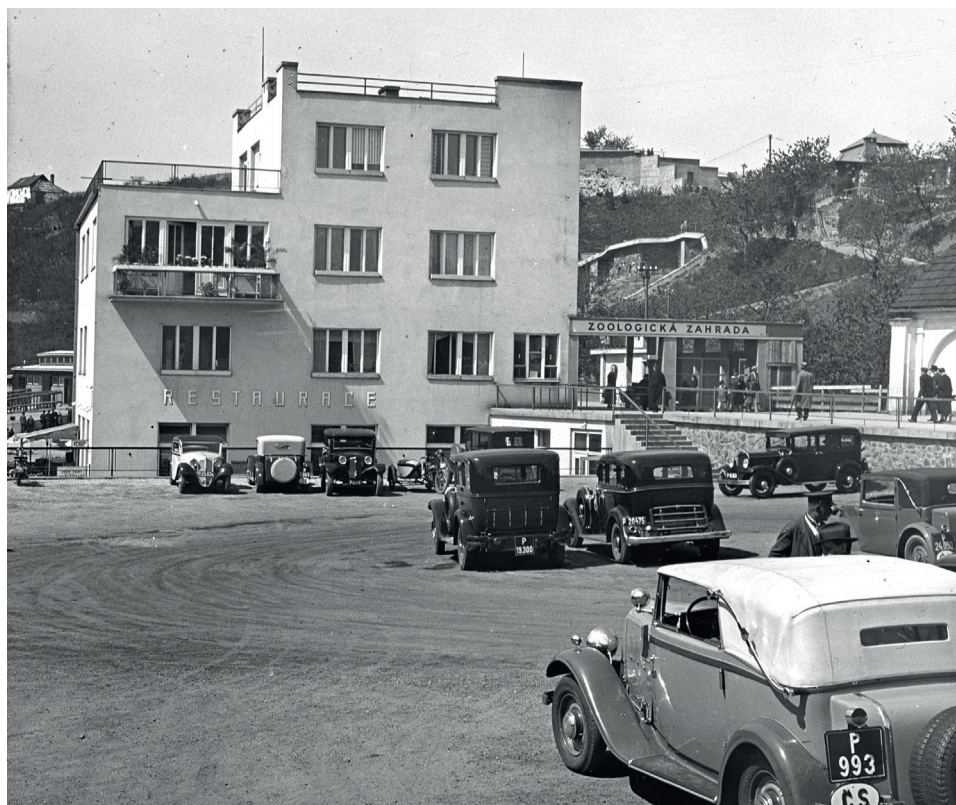
Pohled na vchod do zoo a administrativní budovu, jejíž stavba byla dokončena v červnu 1932. V následujícím roce bylo na dnešní otočce autobusu zřízeno parkoviště pro auta. Archiv zoo Praha A view of the entrance to the Zoo and the office building, completed in June 1932. The following year, a car park was established in the area used today by turning buses. Prague Zoo archives
