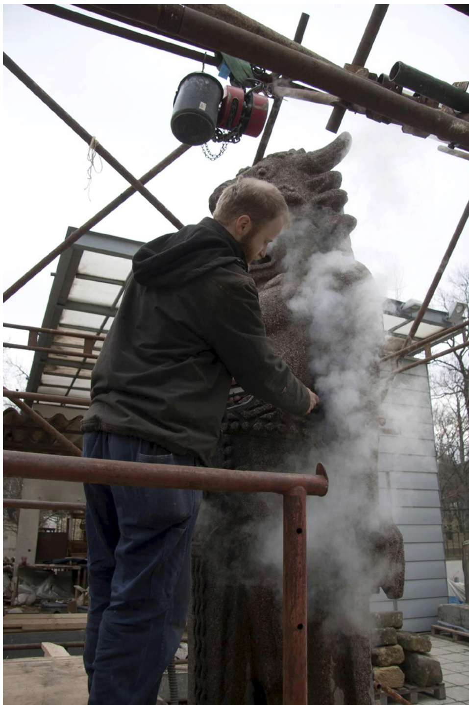
Čištění sochy pomocí tlakové páry Cleaning the sculpture by compressed steam
