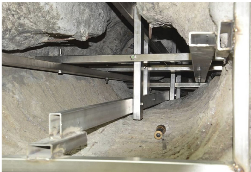
Podpůrná nerezová konstrukce vsunutá do nitra sochy Support stainless steel structure inserted inside the sculpture
