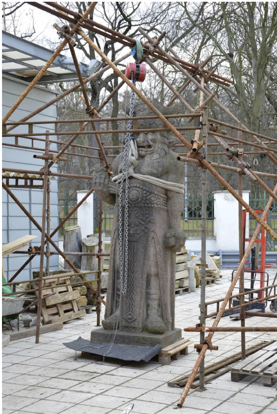
Pomocná manipulační konstrukce An auxiliary handling structure
