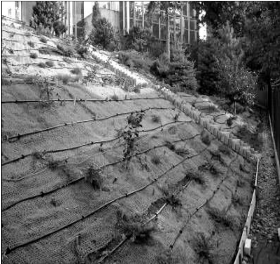
Příklad instalace kapkovacího potrubí ve svahu
