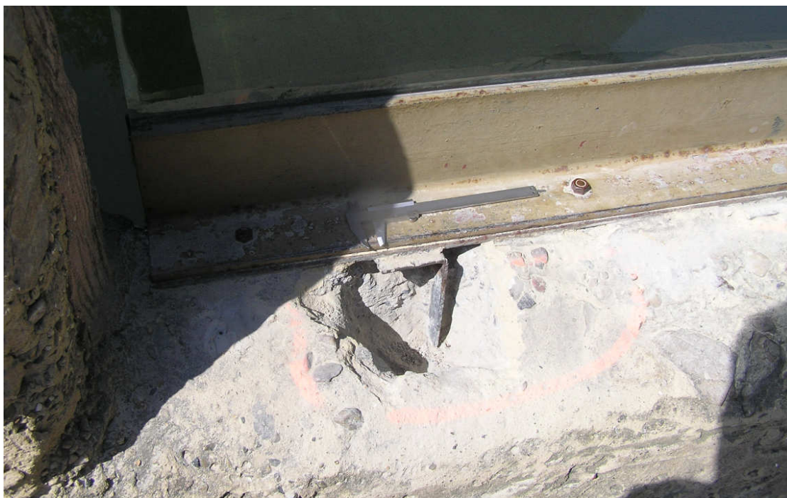
Obr. D2 – Foto detailu odhalené kotvy z pásky z Pl. 48.6
