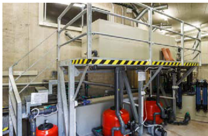
Pohled do technického zázemí s filtračními jednotkami, retenční nádrží a ochozem kolem oddělovacích nádrží s mladými velemloky
