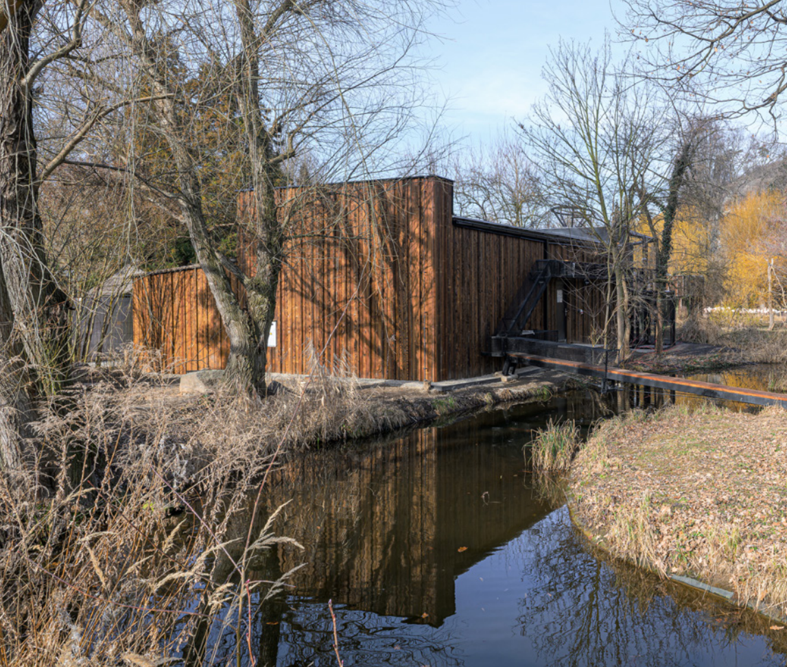
Ostrov pro malpy včetně ubikace byl v roce 2025 dokončen.
