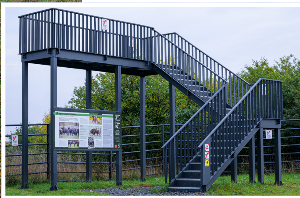
Pohled na areál pro zubry v Dolních Počernicích. Návštěvníci mohou pozorovat zvířata z vyvýšené vyhlídky.
